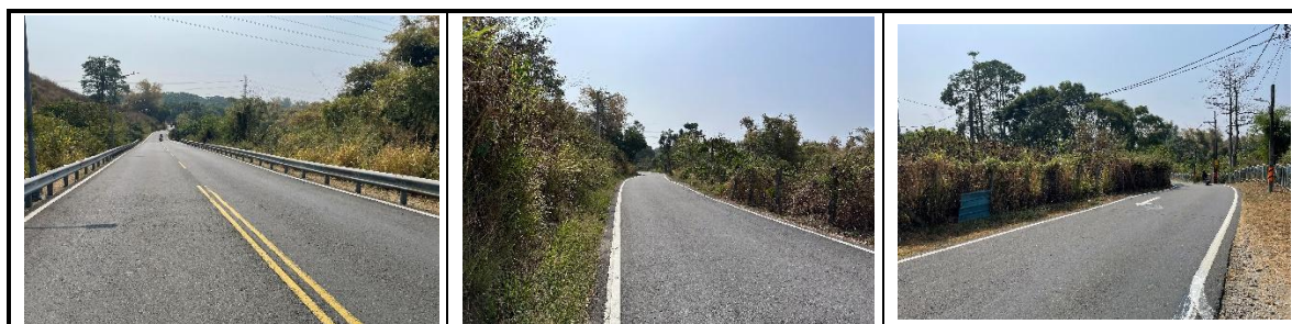
圖 7 天池路現況照片
